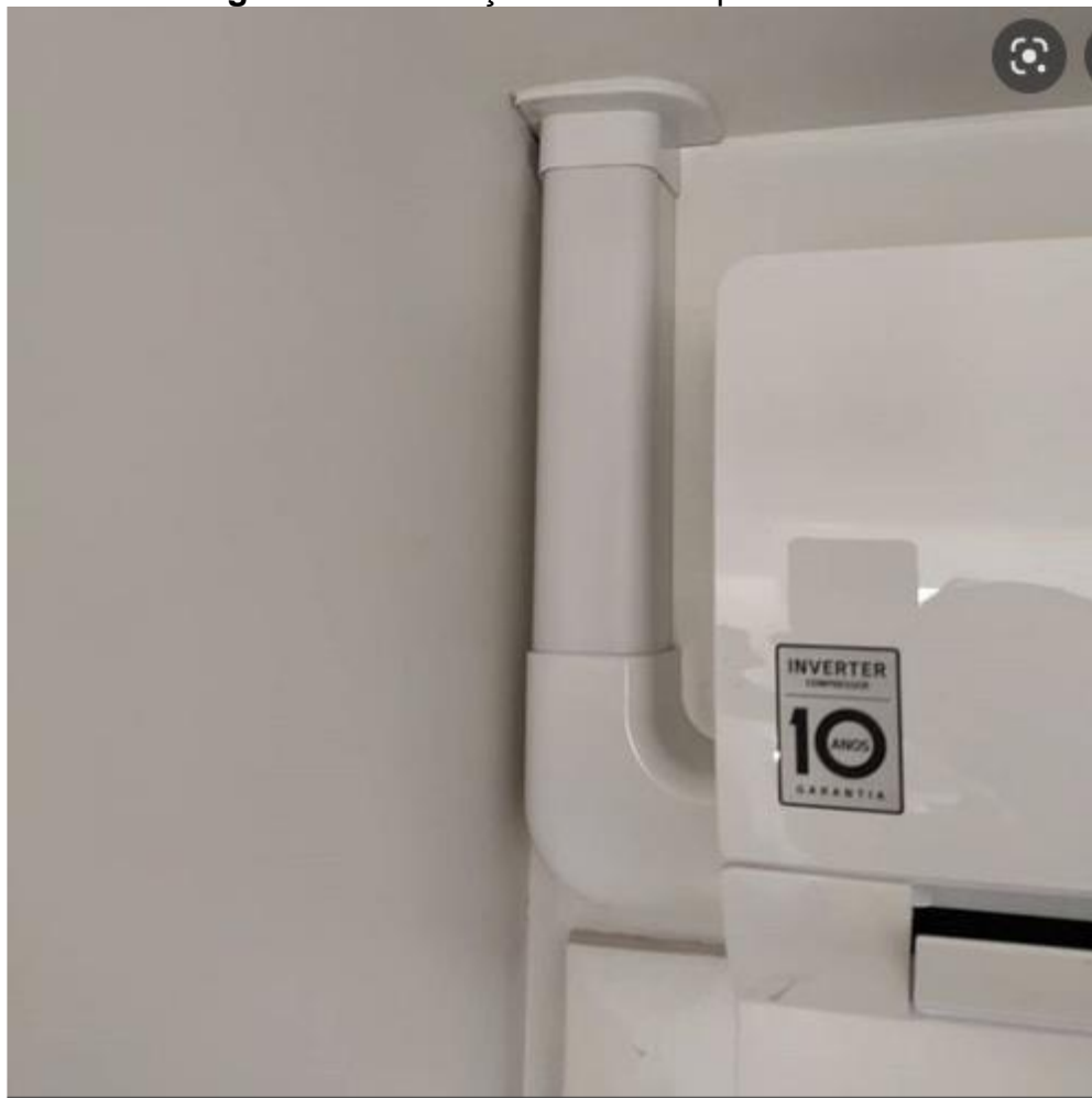
Figura 11: Tubulação de dreno aparente
